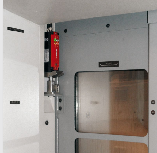
Sécurisation d'une porte coulissante
