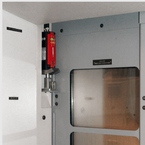
Zabezpieczenie jednych drzwi przesuwnych
