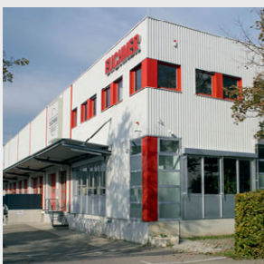
Logistické centrum Leinfelden-Echterdingen
