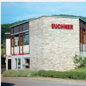
Site de production Unterböhringen
